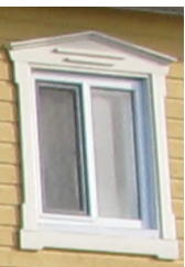
dimensions des chambranles : 100 mm @ 150 mm de largeur
