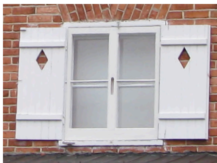
dimensions des chambranles : 100 mm @ 150 mm de largeur
