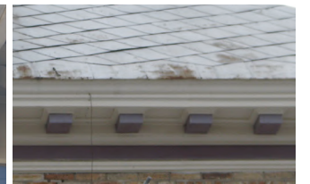
corniches à modillons
