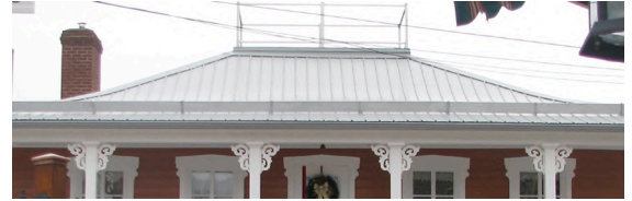
toit à quatre versants avec terrasse
