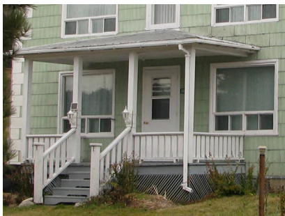
toit distinct, centré, à trois versants
