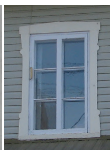
dimensions des chambranles : 100 mm @ 150 mm de largeur
