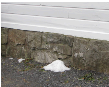
pierres avec mortier
