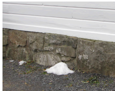
pierres avec mortier
