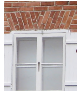
détails de linteaux en brique
