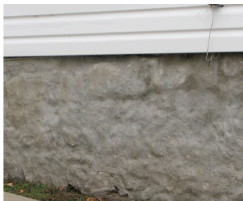
pierres recouvertes de crépi
