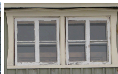
dimensions des chambranles : 100 mm @ 150 mm de largeur
