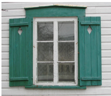
dimensions des chambranles : 100 mm @ 150 mm de largeur
