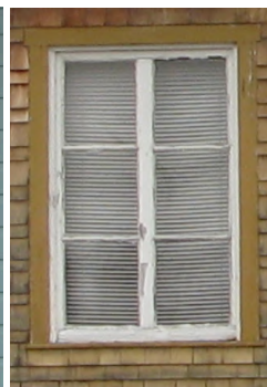
véritables carreaux de part et d'autre du vitrage moustiquaires pour les fenêtres
