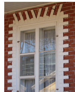
détails de linteaux en brique
