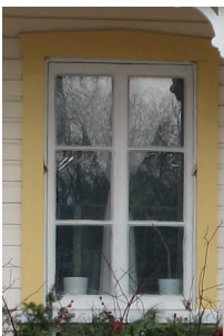
dimensions des chambranles : 100 mm @ 150 mm de largeur
