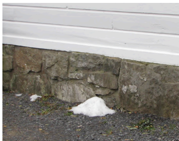
pierres avec mortier
