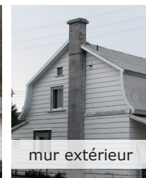
tôle usinée imitant les profilés à baguettes
