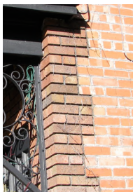
chaînage d'angles sur un revêtement de maçonnerie
