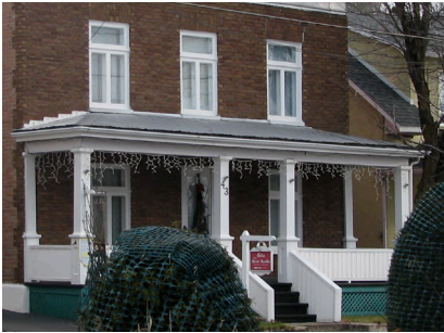
toit distinct, centré, à trois versants
