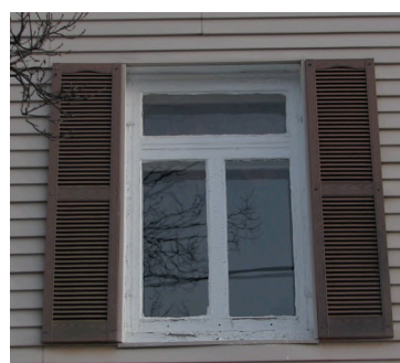
dimensions des chambranles : 100 mm @ 150 mm de largeur
