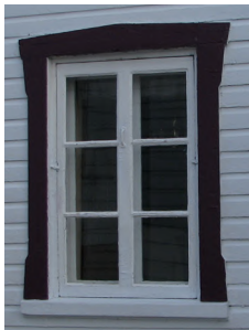
six carreaux au RDC
