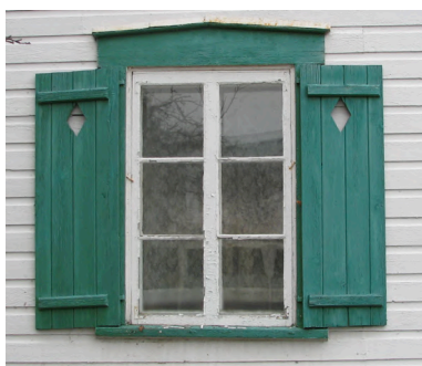
dimensions des chambranles : 100 mm @ 150 mm de largeur
