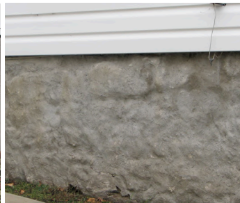
pierres recouvertes de crépi
