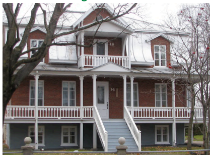
longeant la façade au RDC et balcon à l'étage
