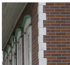
chaînage d'angles sur un revêtement de maçonnerie
