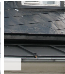
tôle à baguettes
