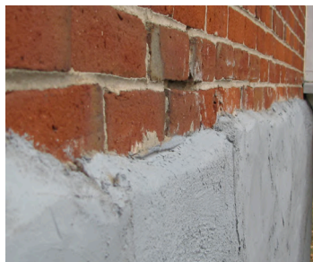
béton recouvert de crépi
