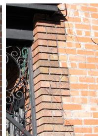
chaînage d'angles sur un revêtement de maçonnerie
