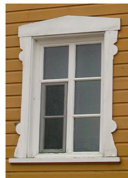
véritables carreaux de part et d'autre du vitrage
