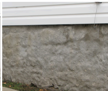
pierres recouvertes de crépi
