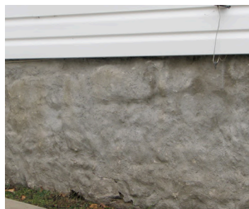
pierres recouvertes de crépi
