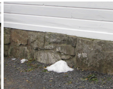
pierres avec mortier
