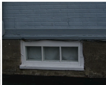
béton recouvert de crépi
