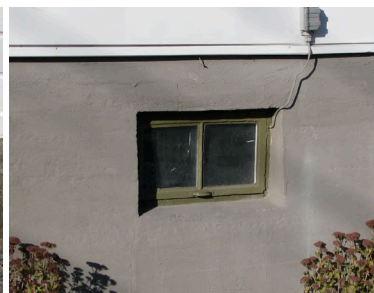
béton recouvert de crépi
