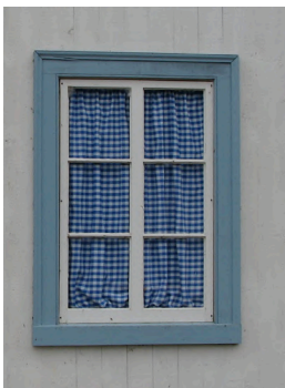
dimensions des chambranles : 100 mm @ 150 mm de largeur
