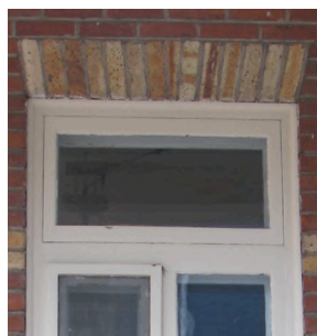
linteaux en brique
