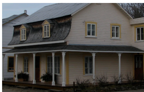
toit distinct longeant deux façades
