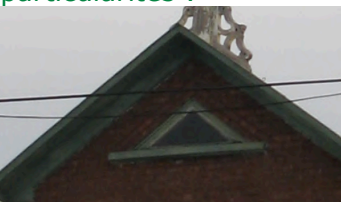
fenêtre triangulaire dans le pignon
