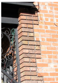
chaînage d'angles sur un revêtement de maçonnerie
