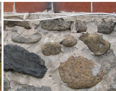
pierres avec mortier
