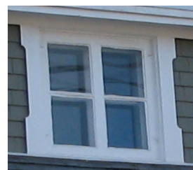
dimensions des chambranles : 100 mm @ 150 mm de largeur
