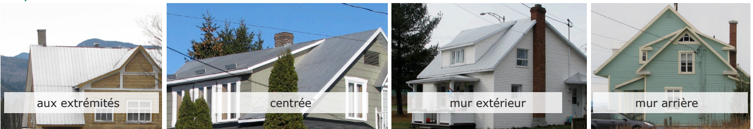
tôle usinée imitant les profilés à baguettes
