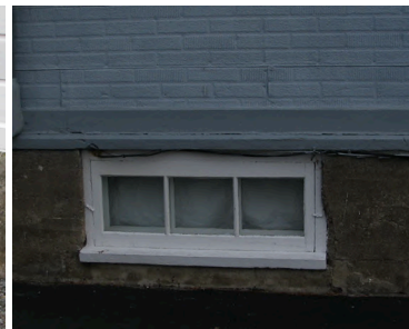
béton recouvert de crépi
