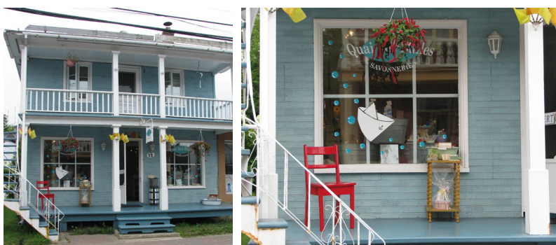
vitrines au RDC avec muret sous celles-ci
