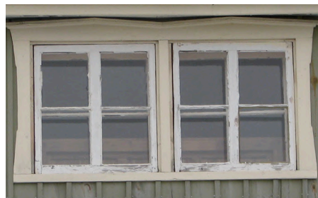
dimensions des chambranles : 100 mm @ 150 mm de largeur
