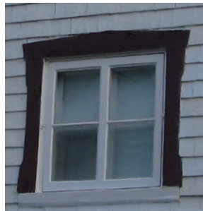
quatre carreaux à l'étage
