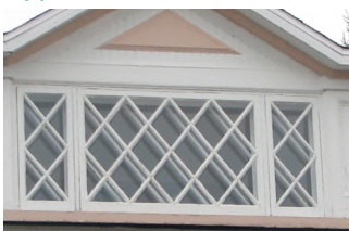
fenêtres avec contre-fenêtres
