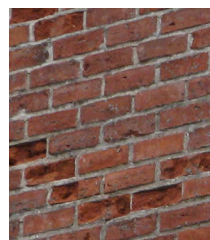
brique d'argile avec mortier
