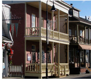
galeries au RDC et à l'étage longeant la façade, prolongement du toit principal ou toit distinct
