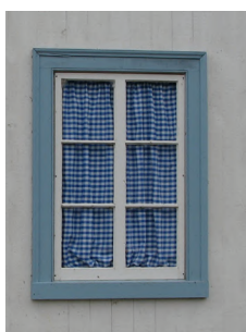
dimensions des chambranles : 100 mm @ 150 mm de largeur
