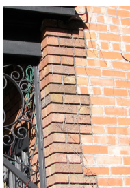
chaînage d'angles sur un revêtement de maçonnerie
