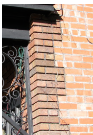
chaînage d'angles sur un revêtement de maçonnerie
