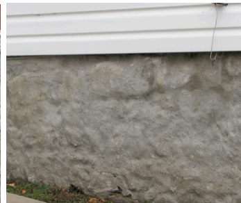
pierres recouvertes de crépi
