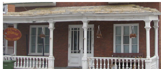
toit distinct, centré, à trois versants
