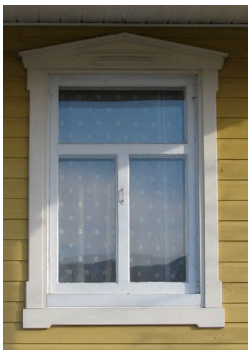
dimensions des chambranles : 100 mm @ 150 mm de largeur
