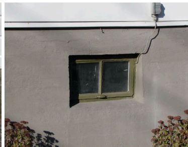
béton recouvert de crépi
