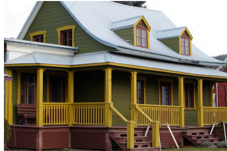
toit distinct sur deux façades
