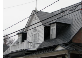
porte et balcon dans la lucarne
