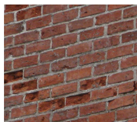
brique d'argile avec mortier
