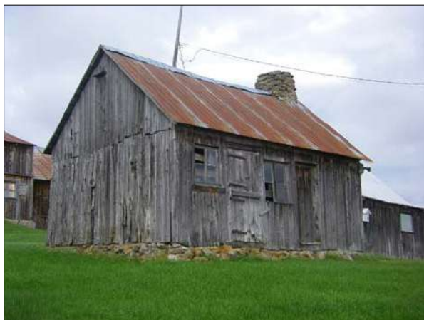
Fournil visible au 418, rang Saint-Pascal, Les Éboulements.
