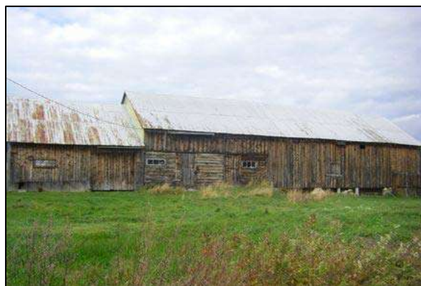
Bâtiment-bloc situé au 414, rang Saint-Pascal, Les Éboulements.
