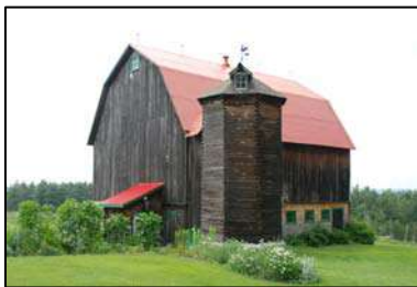
52 Silo de bois de forme octogonale
