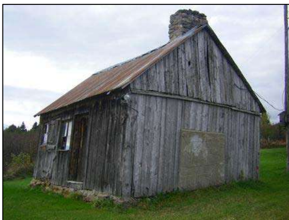
Fournil avec cheminée en maçonnerie, situé au 418, rang Saint-Pascal, Les Éboulements.
