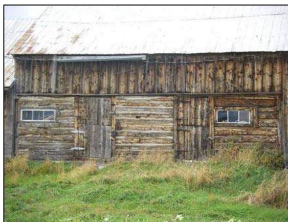
Structure en pièce sur pièce, visible sur la grange-étable située au 414, rang Saint-Pascal, Les Éboulements.
