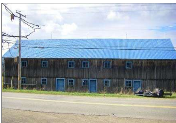
Grange-étable située au 248-254, chemin Saint-Laurent, Baie-Saint-Paul.
