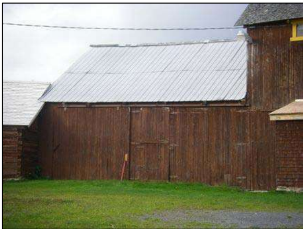
Bâtiment sans larmier situé au 392, rang Saint-Pascal, Les Éboulements.
