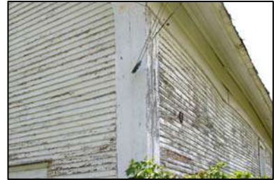
47 Planche cornière soulignant l'angle du bâtiment
