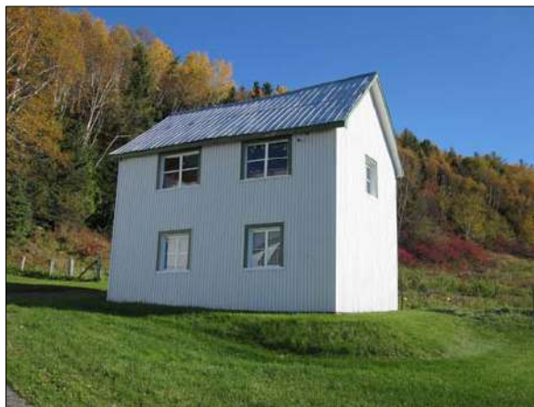
Ancien bâtiment servant probablement à l'origine à entreposer le grain, visible au 105, rang des Éboulements Centre, Les Éboulements.
