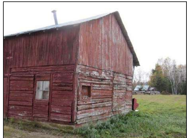
Grange dont les murs du rez-de-chaussée ont été assemblés à tenons à coulisses, visible au 100, rang Saint-Jérôme, Saint-Urbain.
