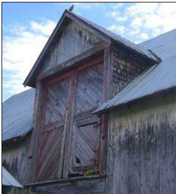
Lucarne de garnaud comportant deux vantaux en bois oblique, visible au 98, rue Ambroise-Fafard, Baie-Saint-Paul.
