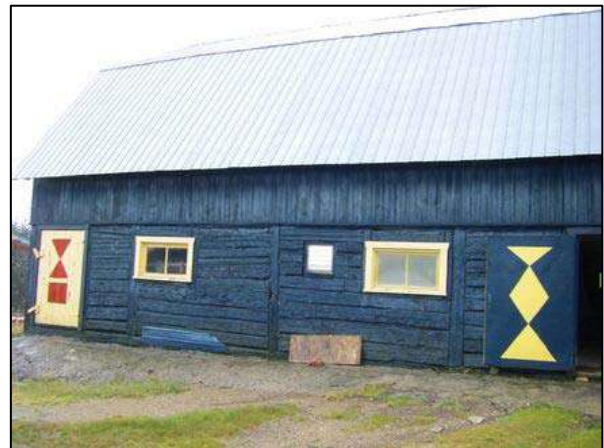
Murs assemblés à tenons à coulisses, visibles au 11, rang Saint-Pierre, Les Éboulements.
