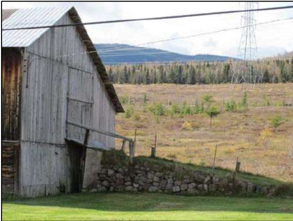
Rampe d'accès en pierres des champs visible au 403, rang Saint-Placide Sud, Baie-Saint-Paul.
