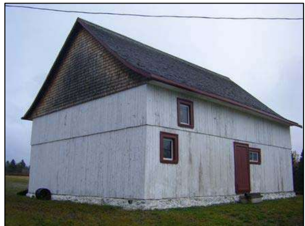
Hangar dont le mur-pignon est recouvert dans la partie supérieure de bardeaux de bois, situé en face au 157, rang Saint-Joseph, Les Éboulements.
