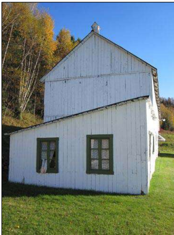
Fenêtres à battants visibles au 105, rang des Éboulements Centre, Les Éboulements.
