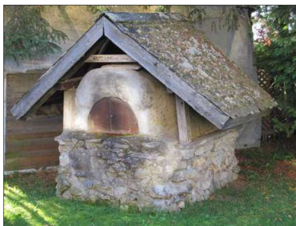
Four à pain situé au 269, rue Félix-Antoine-Savard, Les Éboulements.
