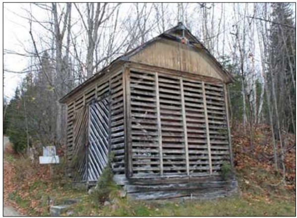
Hangar à bois aux parois ajourées visible dans la rue Félix-Antoine-Savard, Les Éboulements.
