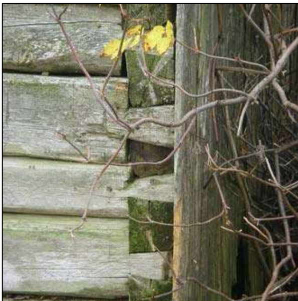
Assemblage à queue d'aronde visible au 19, rang Saint-Antoine, Les Éboulements.
