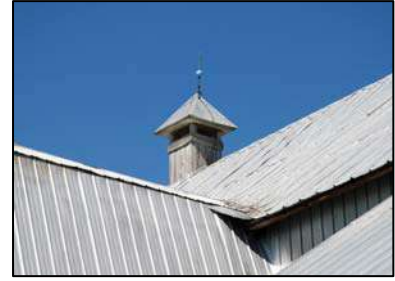
25 Évent disposé au faîte du bâtiment
