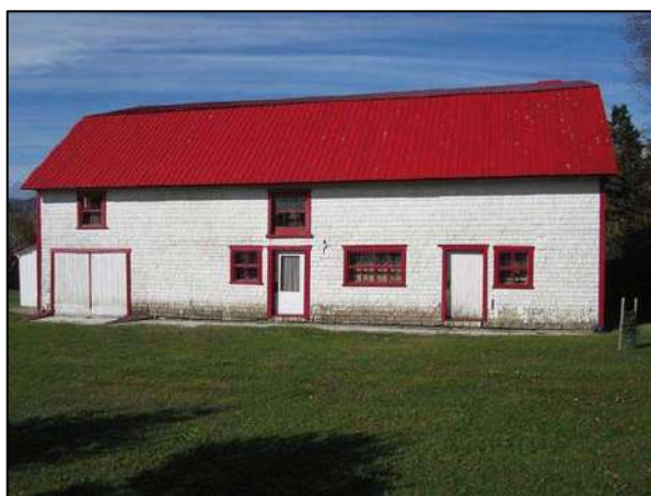
Grange-étable coiffée d'une toiture en tôle de couleur rouge, située au 1224, chemin des Coudriers, L'Isle-aux-Coudres.
