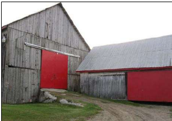
Portes coulissantes abritant la batterie de la grange-étable située au 417, chemin Saint-Laurent, Baie-Saint-Paul.
