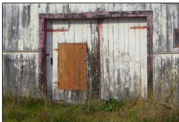
Guichet aménagé dans l'un des vantaux de la porte, visible au 50, rang de Cap-aux-Oies, Les Éboulements.
