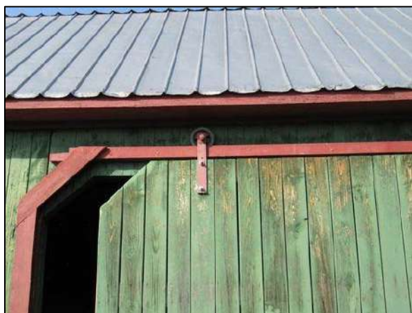
Mécanisme à glissière observable sur le bâtiment agricole situé au 1550, chemin des Coudriers, L'Isle-aux-Coudres.
