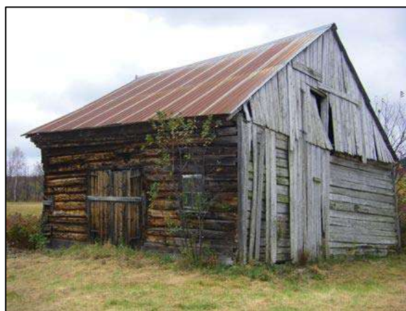
Hangar situé au 19, rang Saint-Antoine, Les Éboulements.
