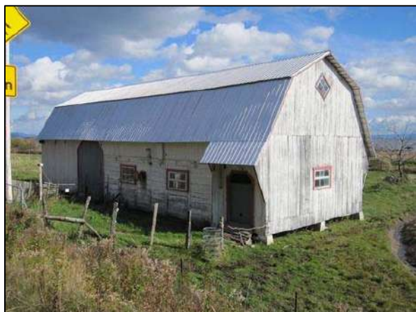
Fenêtre d'aération de la grange-étable située au 636, rue Principale, Petite-Rivière-Saint-François.
