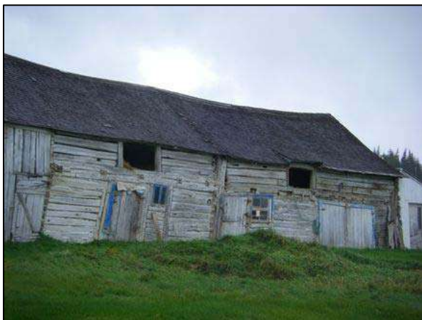
Grange-étable dont les murs en pièce sur pièce ont été blanchis à la chaux, visible au 140, rang Saint-Joseph, Les Éboulements.
