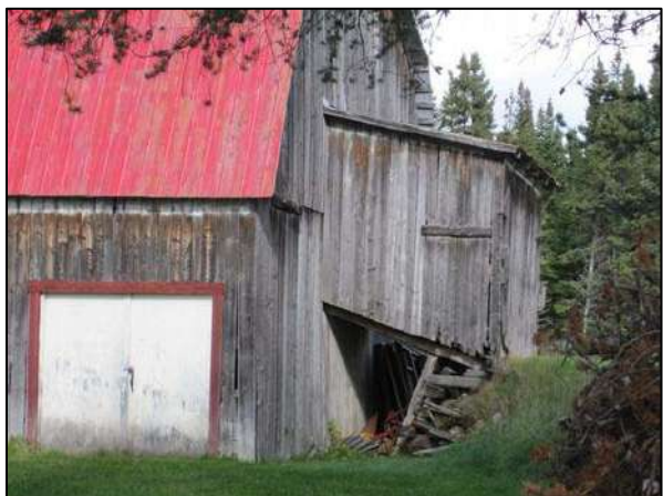
Garnaud couvert d'une toiture en appentis, visible au 1, rue Principale, Petite-Rivière-Saint-François.
