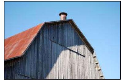
25 Évent disposé au faîte du bâtiment
