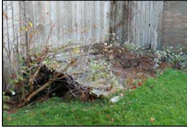
48 Ponceau de bois
