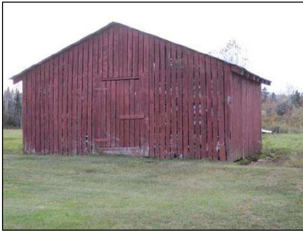
Hangar à bois situé au 100, rang Saint-Jérôme, Saint-Urbain. À remarquer, l'espacement des planches de bois pour laisser sécher le bois.
