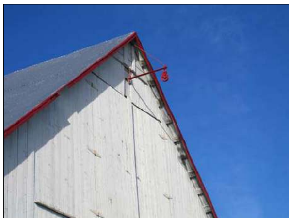
Palan aménagé au sommet du mur pignon de cette grange-étable située au 298, rue du Village, Les Éboulements.
