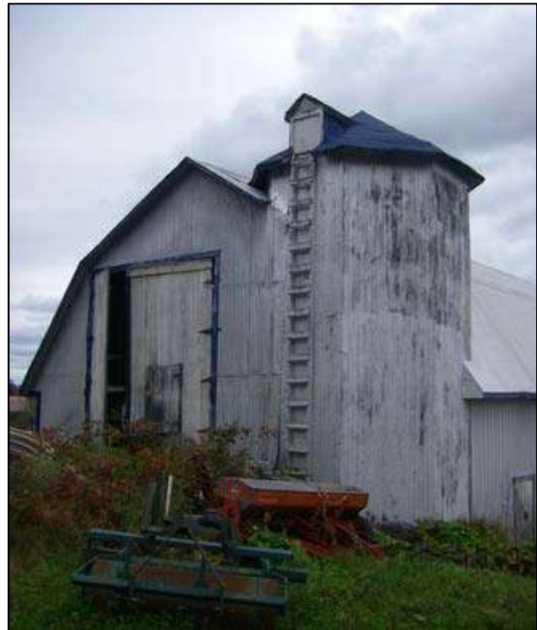
Silo de bois à base octogonale situé au 31, chemin de la Pointe, Baie-Saint-Paul.
