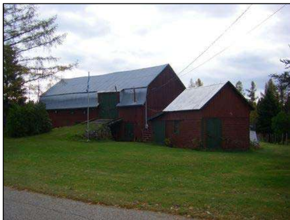
Grange-étable peinte de couleur rouge sang-de-bœuf, située au 110, 5 e Rang Ouest, Saint-Hilarion.
