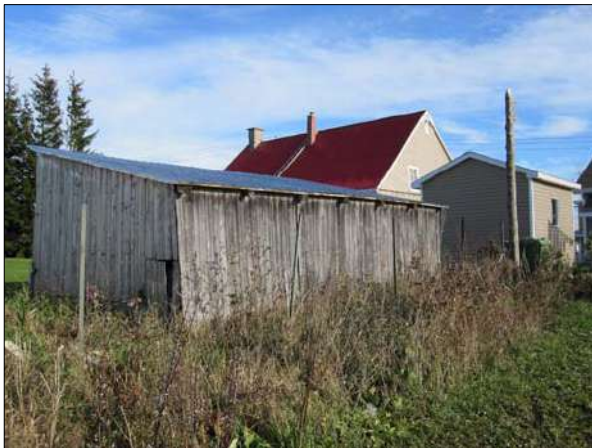
Bâtiment à toit en appentis, 298, rue du Village, Les Éboulements.
