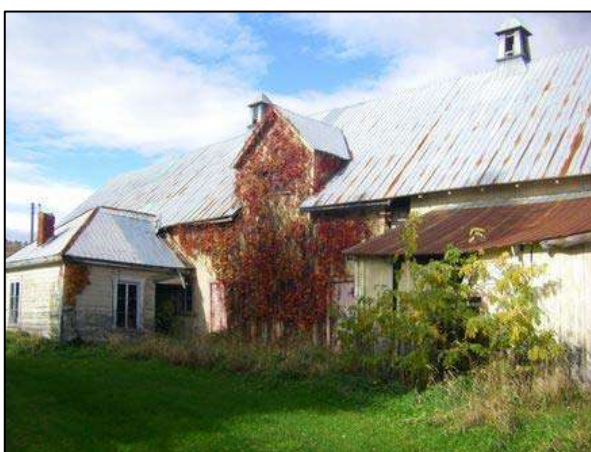
Lucarne de garnaud à pignon sans le pont d'accès d'origine, visible au 98, rue Ambroise-Fafard, Baie-Saint-Paul.
