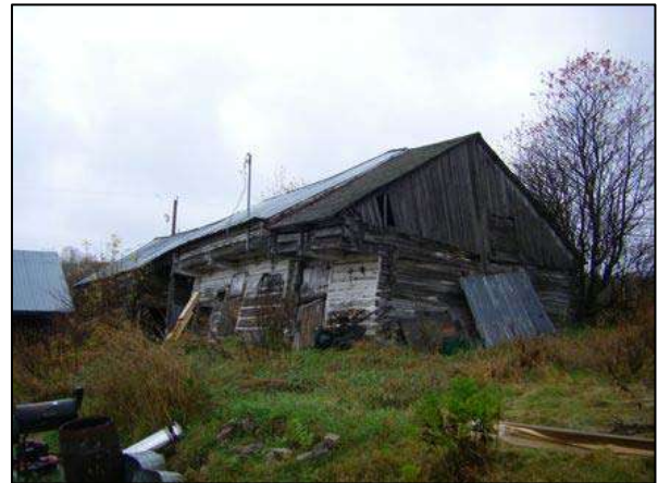
Grange-étable à encorbellement, située au 136, rang Saint-Joseph, Les Éboulements.
