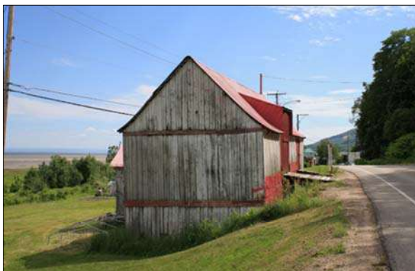
Bâtiment agricole à Petite-Rivière-Saint-François, entre fleuve et falaise.
