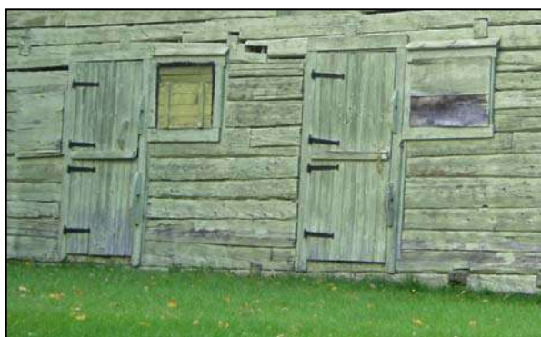
Portes avec ferrures artisanales visibles sur un bâtiment agricole situé au 83, rang de Cap-aux-Oies, Les Éboulements.
