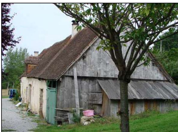
Grange-étable avec mur latéral en bois, Perche.
