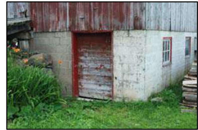
9 Soubassement en blocs de béton
