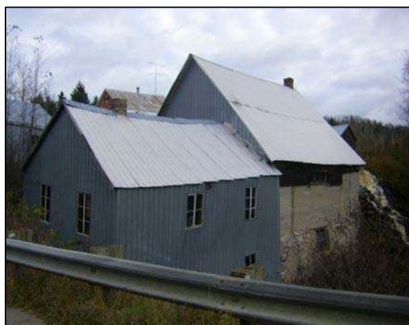
Une partie du moulin Simard, situé au 84, chemin du Moulin, à Saint-Hilarion, est entièrement recouverte de tôle.
