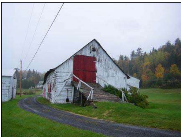
Garnaud visible au 258, côtes des Cèdres, Les Éboulements.
