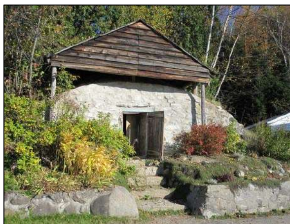
Ce caveau au 89, rang des Éboulements Centre, aux Éboulements, présente la particularité d'être protégé par une toiture à deux versants installée au-dessus de la voûte.
