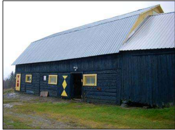
Grange-étable sise au 11, rang Saint-Pierre, Les Éboulements.
