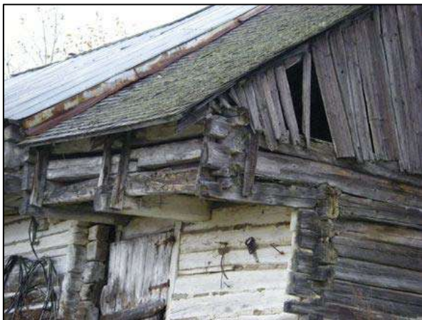
Grange à encorbellement dont la structure est assemblée à mi-bois, située au 136, rang Saint-Joseph, Les Éboulements.
