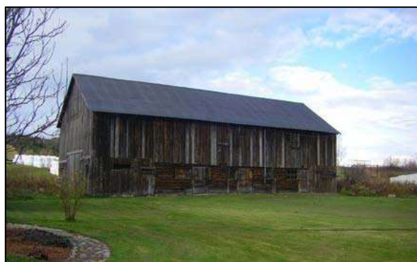
Grange-étable à pignon droit située au 354, rang Saint-Godefroy, Les Éboulements.
