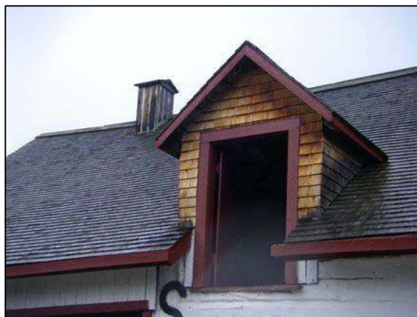
Lucarne d'un bâtiment agricole situé au 157, rang Saint-Joseph, Les Éboulements.
