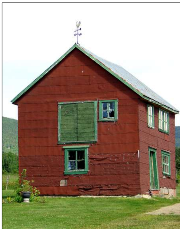
Hangar à grain situé au 406, route 362, Les Éboulements.
