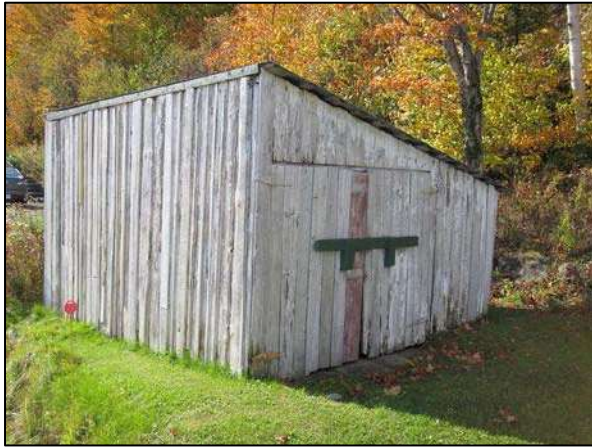
Dépendance coiffée d'un toit en appentis, située au 1408, rue Principale, Petite-Rivière-Saint-François.
