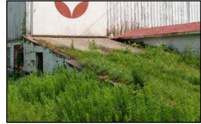
50 Rampe d'accès en béton
