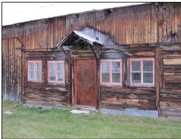
Fenêtres encadrant une porte donnant accès à l'étable, observables au 225, rang Saint-Jean-Baptiste, Saint-Urbain.
