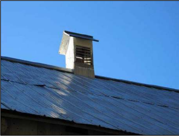
Lanterneau visible au 105, rang des Éboulements Centre, Les Éboulements.
