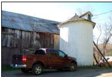
52 Silo de bois de forme cylindrique
