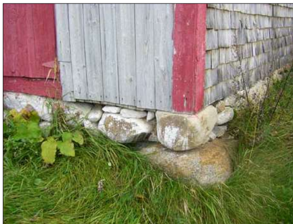
Fondation de pierres sèches, visibles en face du 46, route 138, Saint-Hilarion.
