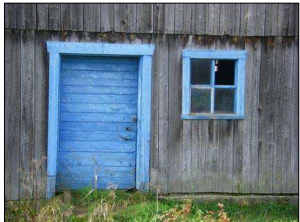
Porte et fenêtre d'une grange située au 248, chemin Saint-Laurent, Baie-Saint-Paul.
