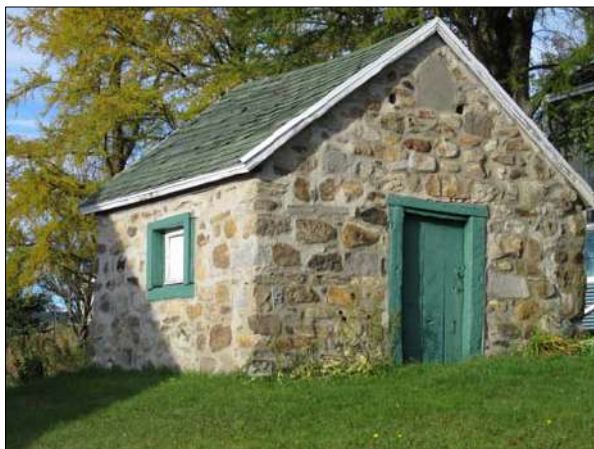
Laiterie en maçonnerie de pierre, 230, rue du Village, Les Éboulements.
