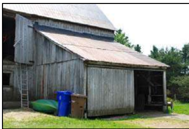
1 Annexe en appentis
