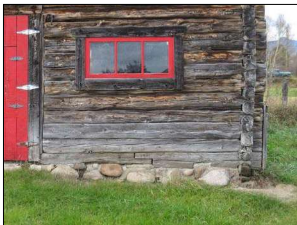
Fenêtre visible au 1325, rang Saint-Edouard, Saint-Urbain.
