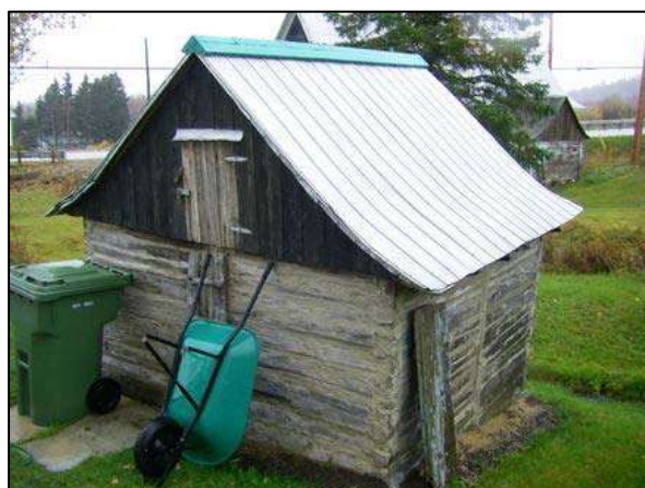
Laiterie dont la toiture a été recouverte de tôle, sise au 128, rang Saint-Joseph, Les Éboulements.
