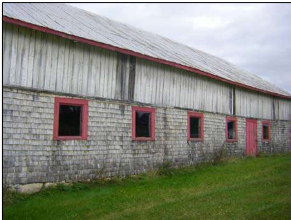
Grange-étable partiellement recouverte de bardeaux de bois, visible en face du 46, route 138, Saint-Hilarion.
