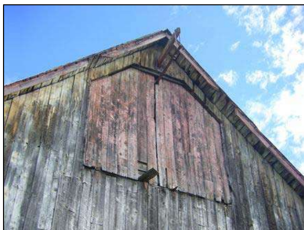
Trappe aménagée dans la partie supérieure du mur pignon d'une grange et palan au 98, rue Ambroise-Fafard, Baie-Saint-Paul.
