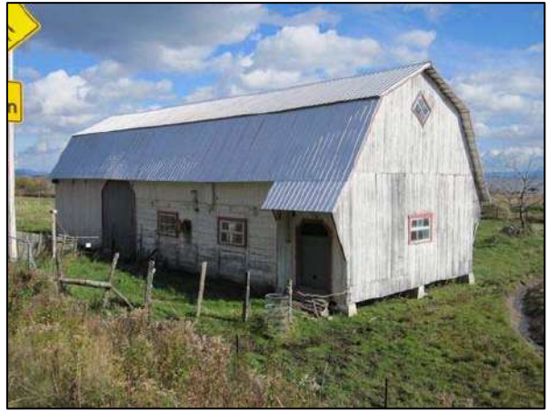
Grange-étable sise au 636, rue Principale, Petite-Rivière-Saint-François.
