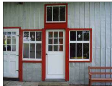
12 Chambranles autour des ouvertures
