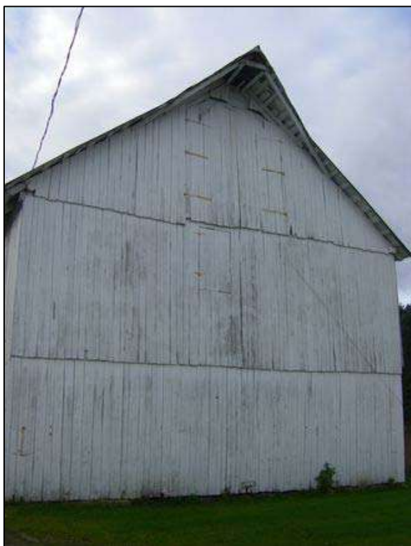
Cette grange-étable était munie d'un coyau de faîtage destiné à protéger des intempéries le système de palan servant à élever des charges au niveau supérieur. 1047, boulevard Monseigneur-De Laval, Baie-Saint-Paul.
