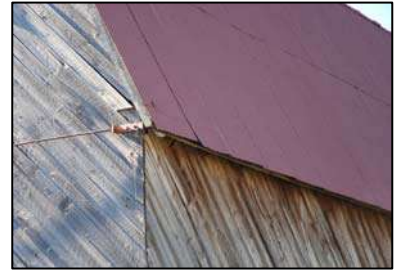
67 Tôle profilée sur le toit
