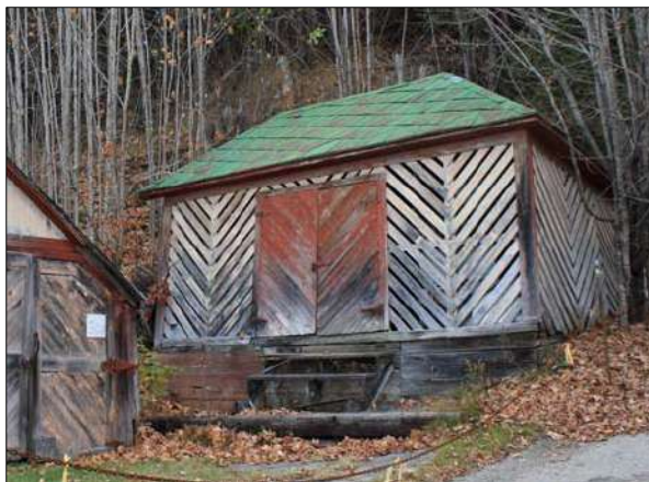
Hangar à bois aux parois ajourées, situé dans la rue Félix-Antoine-Savard, Les Éboulements.
