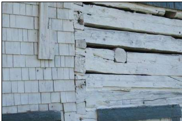
Assemblage à queue d'aronde observable au 81, rang des Éboulements Centre, Les Éboulements.
