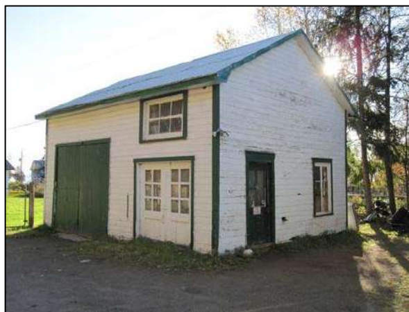
Planches cornières et chambranles de portes et de fenêtres visibles au 269, rue Félix-Antoine-Savard, Les Éboulements.
