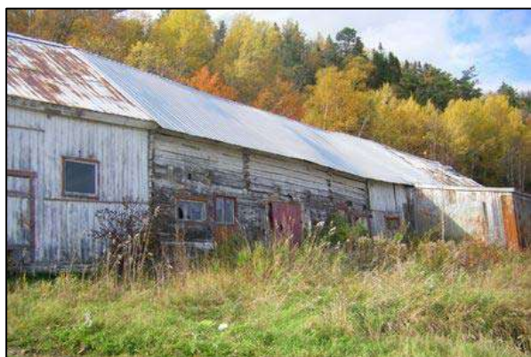
Bâtiment-bloc visible au 50, rang de Cap-aux-Oies, Les Éboulements.
