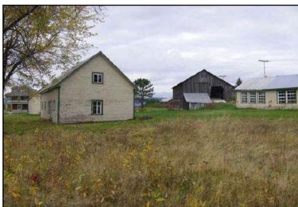
Ensemble exceptionnel comprenant une fromagerie, un poulailler, un hangar à bois et une grange-étable, disposés aléatoirement près de la maison sise au 97, route 138, Saint-Hilarion.
