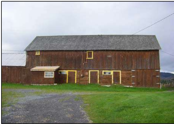
Des bardeaux de bois recouvrent la toiture de cette grange-étable située au 392, rang Saint-Pascal, Les Éboulements.
