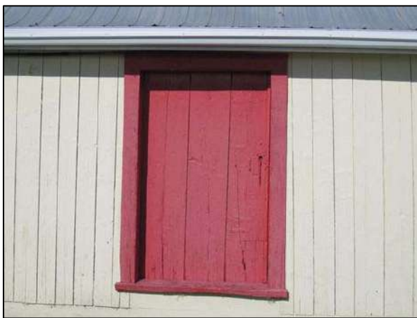
Porte visible au 358, chemin de La Baleine, L'Isle-aux-Coudres.
