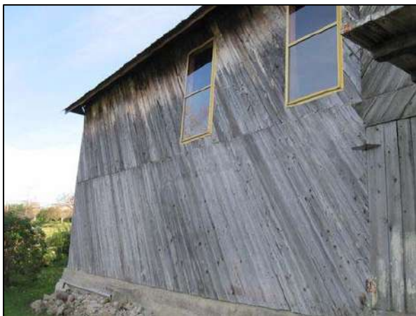
Façade arrière d'une grange-étable arborant des planches disposées en oblique, située au 1224, chemin des Coudriers, L'Isle-aux-Coudres.
