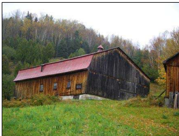
Située au 242, côte des Cèdres, aux Éboulements, cette grange-étable a la particularité d'être coiffée d'un toit brisé à base recourbée à l'avant, et à un versant droit à l'arrière.
