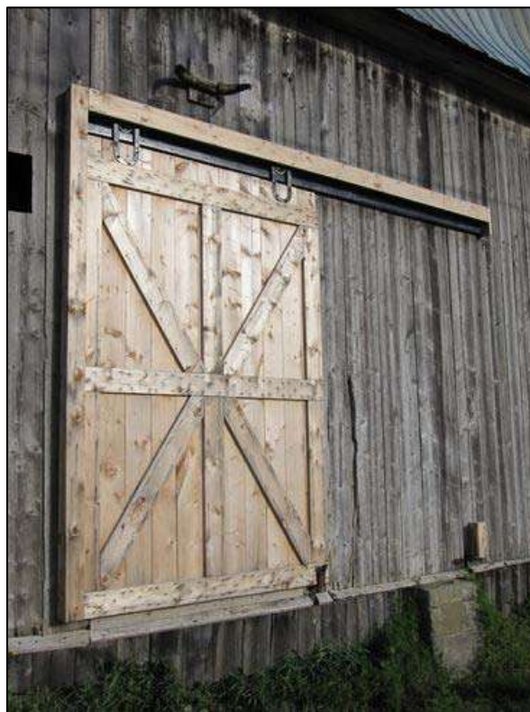
Grange-étable sise entre le 293 et le 297, rue du Village, Les Éboulements.
