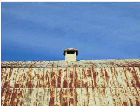
Évent de toiture visible au 1238, chemin des Coudriers, L'Isle-aux-Coudres.
