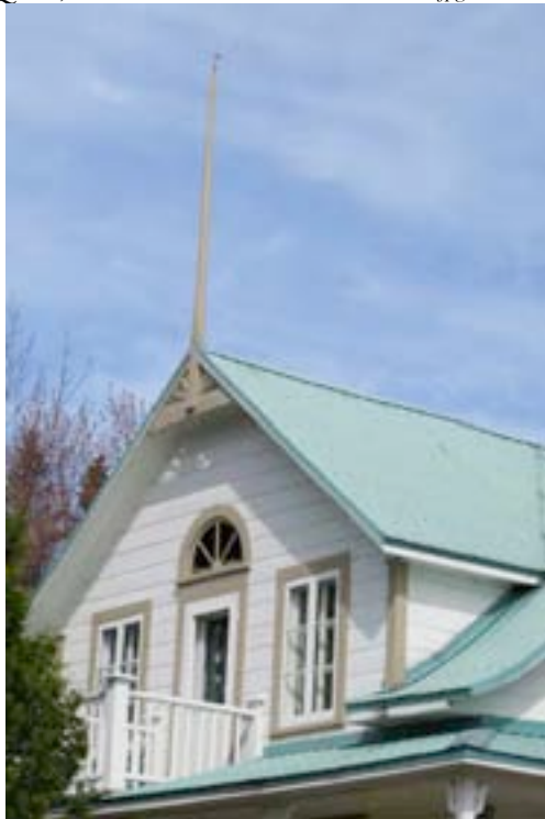
Mât surplombant la vaste lucarne triangulaire de la maison du capitaine J.A.Z. Desgagnés, 282, rue Félix-Antoine-Savard, Les Éboulements. BIMG_0001.jpg
