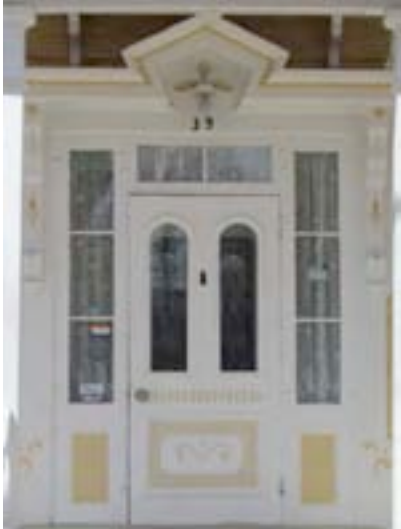
Porte avec vitres en arc plein cintre, mise en valeur par des baies latérales, une imposte et un fronton. 39, rue Saint-Jean-Baptiste, Baie-Saint-Paul. IMG_3031.jpg
