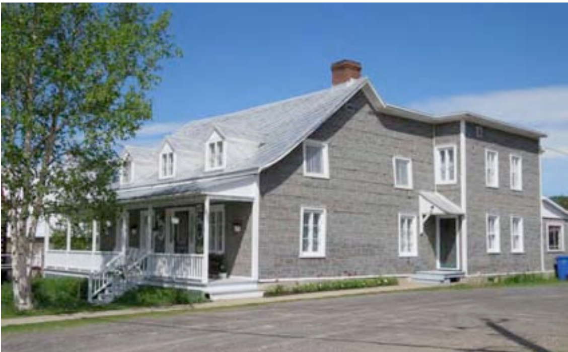
Le 2405, route du Fleuve, Les Éboulements, en 2014. Il est intéressant de constater que le rehaussement du versant arrière a été effectué il y a fort longtemps. Depuis la parution de la carte postale, peu de changements ont été effectués à l'édifice à part le remplacement du garde-corps (des barreaux à la place des éléments en fonte moulée). BIMG_0386.jpg
