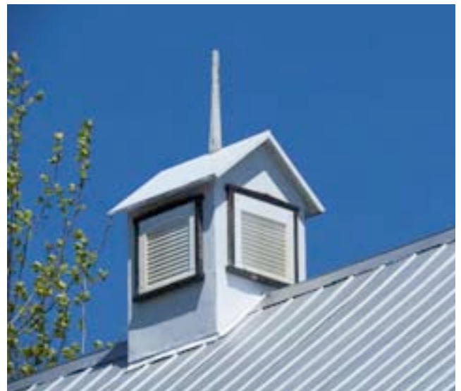
Lanterneau. 36, chemin du Cap-aux-Corbeaux Nord, Baie-Saint-Paul. IMG_5588.jpg
