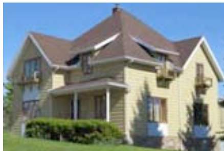
Exemple d'un édifice «hors type», le 2342, route du Fleuve, Les Éboulements. À cause des décrochés et avant-corps, il ne peut être associé à la maison cubique.
