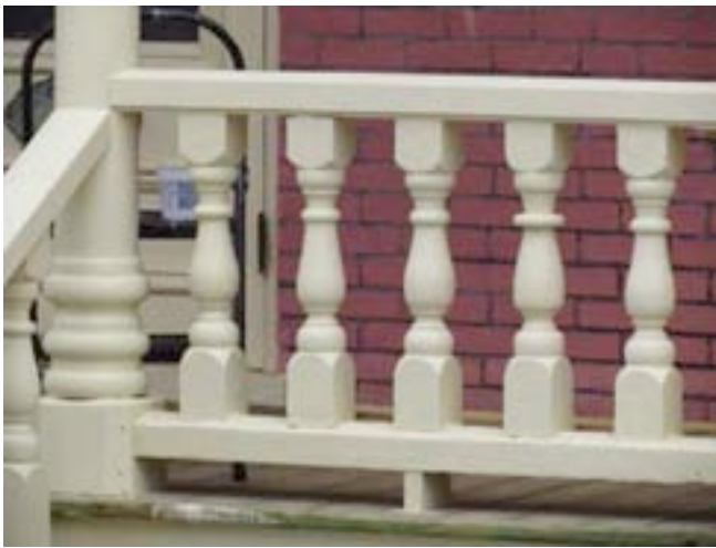
Base d'une colonne tournée et magnifiques balustres formant la balustrade. 120, rue Saint-Jean-Baptiste, Baie-Saint-Paul. IMG_3698.jpg
