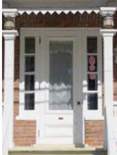
Porte à vitrage simple avec baies latérales au 30, rue Ambroise-Fafard, Baie-Saint-Paul. IMG_3067.jpg
