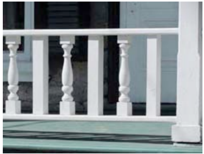
Forme peu courante de garde-corps intégrant balustres et barreaux droits. Maison Otis, 23, rue Saint-Jean-Baptiste, Baie-Saint-Paul. IMG_3155.jpg
