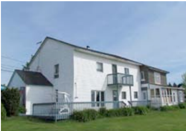
La maison Georges-Dufour, 402, chemin de La Baleine, L'Isle-aux-Coudres. On a effectué des interventions sur les revêtements muraux, les fenêtres (modèle, dimensions) et les portes notamment. IMG_7932.jpg
