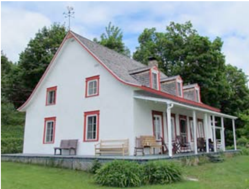
L'un des plus anciens édifices à fonction résidentielle inclus dans notre inventaire : le 8, rang des Éboulements-Centre, Les Éboulements. IMG_8709.jpg
