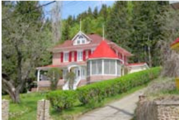
Le 332, rue Félix-Antoine-Savard, Les Éboulements, un édifice érigé en 1910. BIMG_0063.jpg
