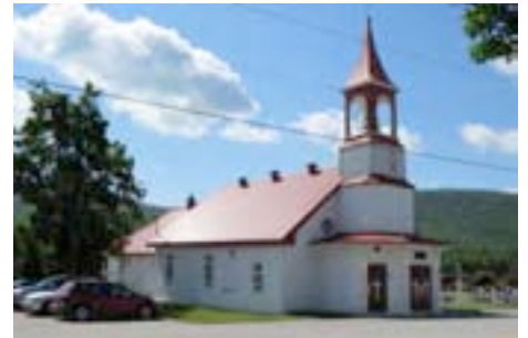
L'église Saint-Placide au 292, rang Saint-Placide Sud, Baie-Saint-Paul. BIMG_2069.jpg
