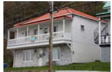
Exemple d'un édifice «hors type», le 924, rue Principale, Petite-Rivière-Saint-François. Un édifice de plan rectangulaire au toit à quatre versants. BIMG_5283.jpg
