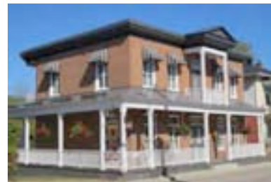
Exemple d'édifice à toit plat, le 29, rue Sainte-Anne, Baie-Saint-Paul.
