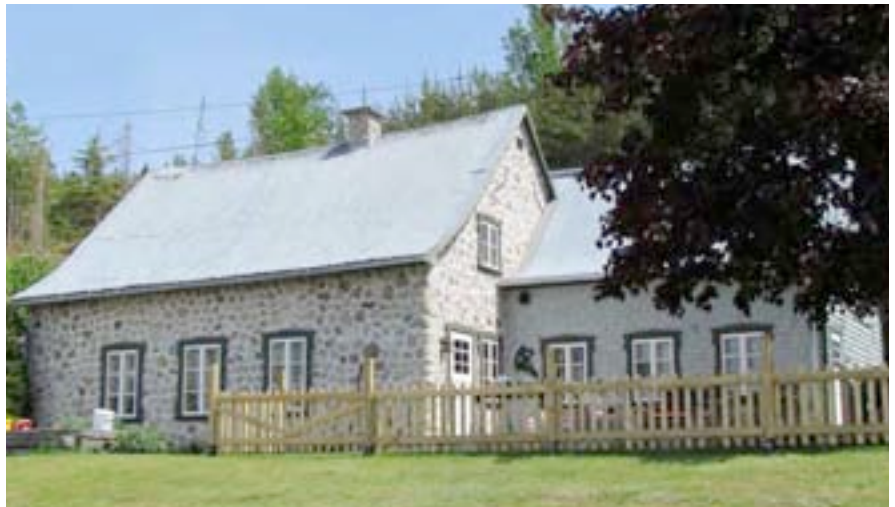
Ouvertures extrêmement bien préservées ou mises en valeur sur cet imposant édifice en pierre avec sa cuisine d'été revêtue de bardeau de bois. 176, rang Saint-Jean-Baptiste, Saint-Urbain. IMG_3155.jpg
