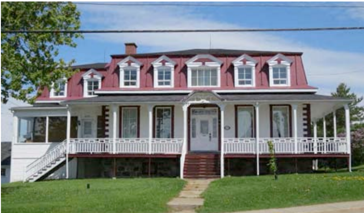
Le presbytère de l'Assomption-de-la-Sainte-Vierge, en 2014. Outre le remplacement des fenêtres, l'édifice possède ses autres caractéristiques identitaires, dont la lucarne centrale monumentale et les chaînes d'angle. 2293-2295, route du Fleuve, Les Éboulements. BIMG_0360.jpg
