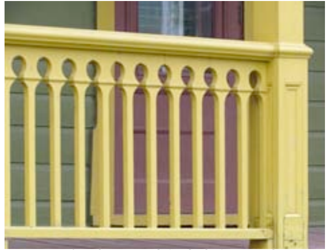
Un autre fort beau modèle de balustres découpés au 113, rue Saint-Joseph, Baie-Saint-Paul. IMG_4319.jpg
