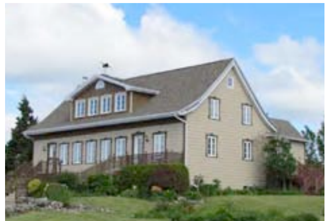
Le 1567, route du Fleuve, Les Éboulements, en 2014. Une lucarne comparable aux lucarnes d'ornement typique de Charlevoix a été mise en place, tout comme un revêtement s'approchant de la planche à clin. En outre, les fenêtres modernes s'apparentent au modèle d'origine à battants à grands carreaux. Au final, une intervention intéressante. IMG_8543.jpg
