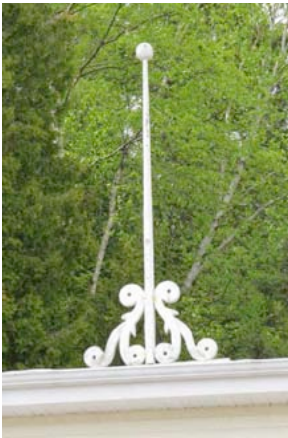
Mât surplombant le toit de l'ancien magasin général Rodolphe-Tremblay. 228-230, rue Félix-Antoine-Savard, Les Éboulements. BIMG_0237.jpg
