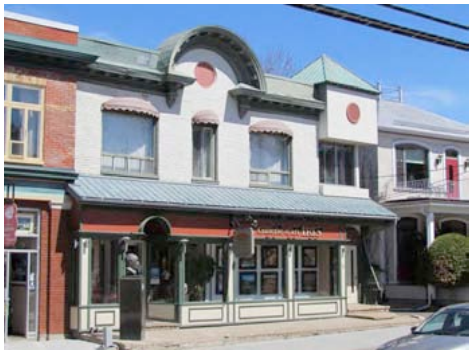
Le 30, rue Saint-Jean-Baptiste, Baie-Saint-Paul, en 2014. Les transformations subies sont très importantes. Parmi elles, figure notamment la disparition du revêtement de brique, des fenêtres à imposte et de l'oculus. En outre, le changement de vocation de l'immeuble a entraîné le remplacement de la galerie couverte par des vitrines. IMG_3385.jpg
