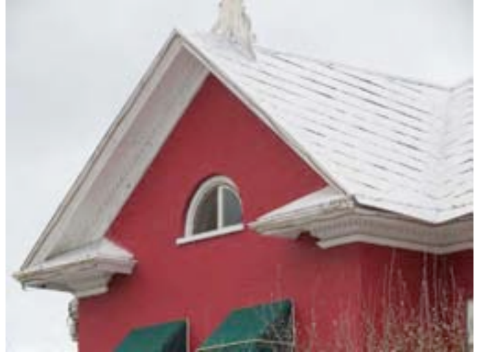
Fronton avec, à sa base, des retours de corniche. Ancien hôpital Saint-Paul au 160, rue Saint-Jean-Baptiste, Baie-Saint-Paul. IMG_3758.jpg
