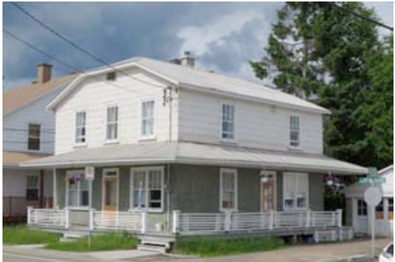
La fenestration de cet édifice, tout comme son revêtement de bardeau d'amiante, nous plongent tout droit au cœur des années 1950, dans l'esprit du courant architectural Arts and Crafts. 910, rue Saint-Édouard, Saint-Urbain. BIMG_1669.jpg
