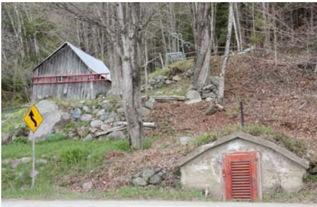
Disposition typique de bâtiments secondaires aménagés en palier, le long de la falaise à Petite-Rivière-Saint-François, dont un caveau à légumes littéralement incrusté dans le sol. BIMG_5538.jpg
