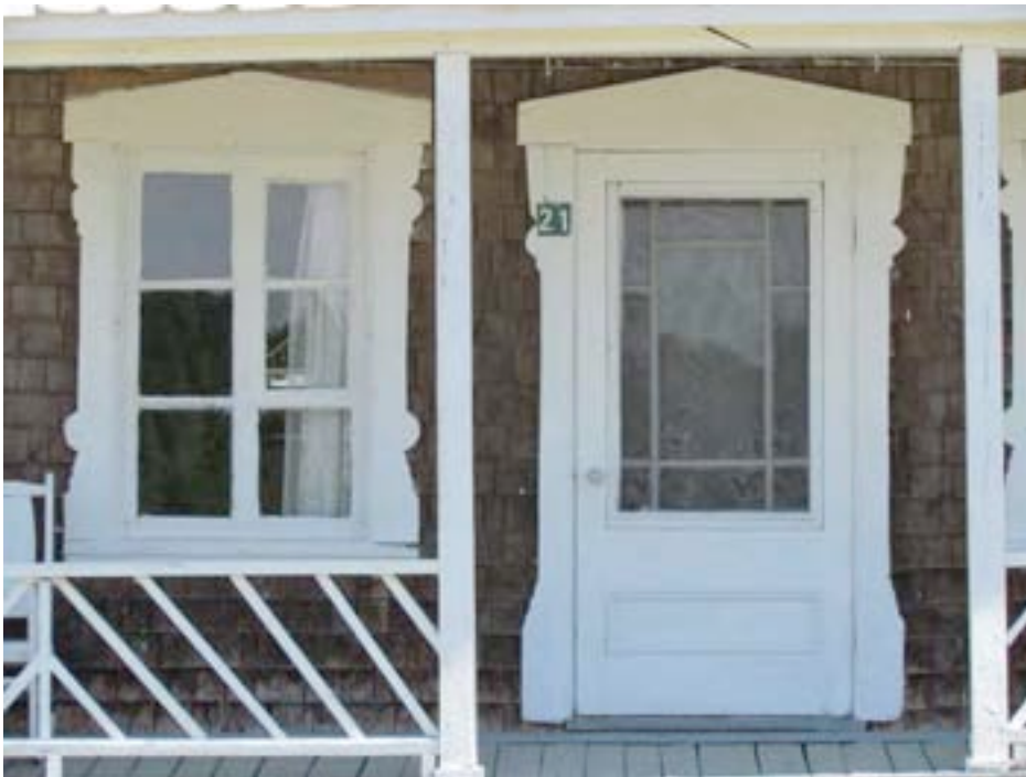
Chambranles découpés, fenêtres à battants à six grands carreaux, porte à menuiserie d'assemblage et revêtement de bardeau contribuent à la qualité de l'authenticité du 21, route Sainte-Croix, Saint-Hilarion. IMG_4398.jpg
