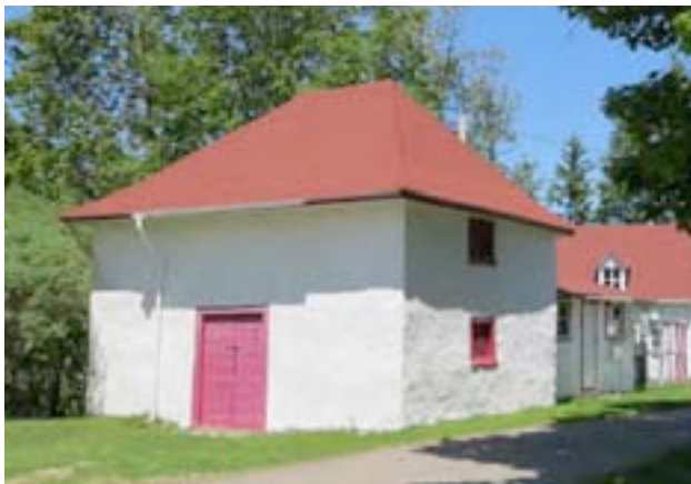
L'ancienne laiterie du domaine seigneurial de Sales Laterrière, un bâtiment unique en son genre dans la MRC. 2058, chemin du Fleuve, Les Éboulements. BIMG_0932.jpg
