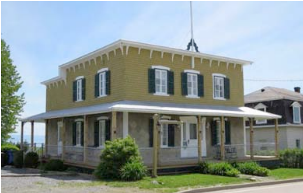
Le 2405, route du Fleuve, Les Éboulements, en 2014. Érigé en 1913, cet édifice, qui logea une succursale de la Banque Canadienne Nationale, offre un aspect très proche de celui d'origine. Les deux types de revêtements, les fenêtres à battants à grands carreaux, la porte à baies latérales et les consoles de la corniche en témoignent. IMG_0551.jpg
