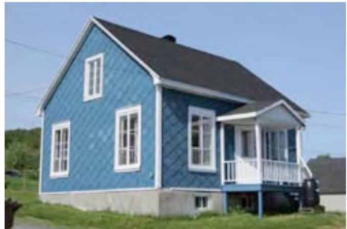
Le 1925, route du Fleuve, Les Éboulements, un édifice à valeur patrimoniale supérieure. BIMG_1407.jpg
