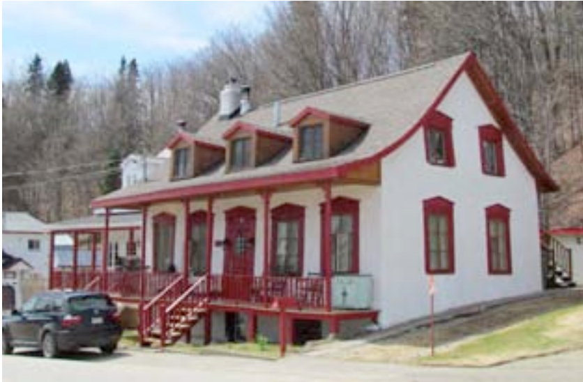
L'un des édifices possédant une valeur d'âge, le 8 chemin de la Pointe, à Baie-Saint-Paul, puisqu'il a été érigé bien avant 1850, soit aux environs de 1736.
