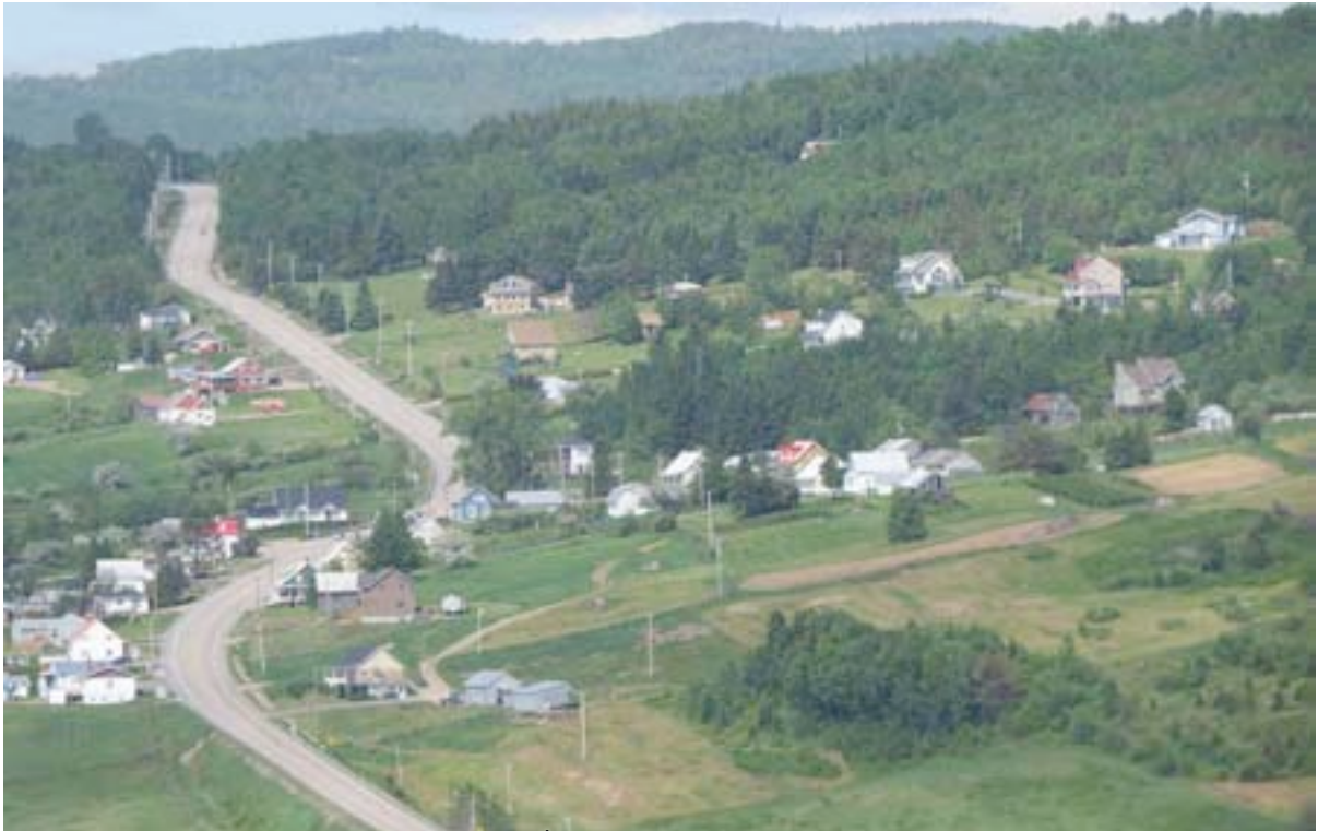
La route du Fleuve et ses abords aux Éboulements, depuis le cimetière paroissial, en direction ouest. Un environnement naturel exceptionnel qui met en valeur le cadre bâti ancien. IMG_0380.jpg
