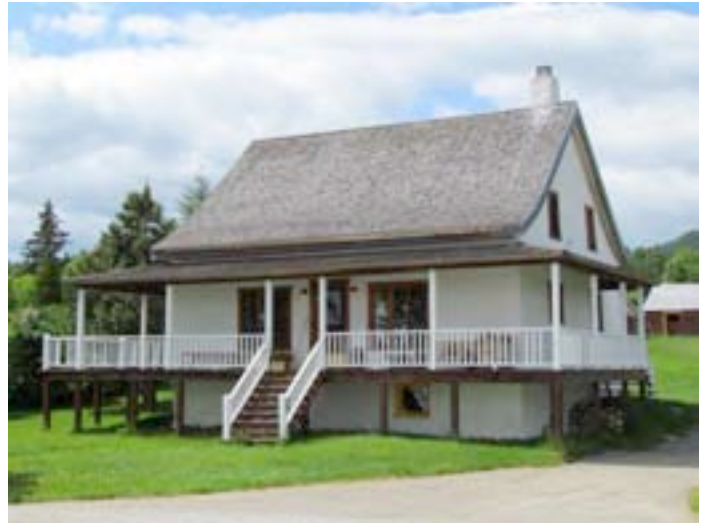
La maison Audet qui pourrait dater des années 1714-1715. Le 2847, route du Fleuve, Les Éboulements. IMG_8383.jpg
