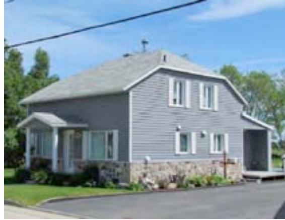
Le 1998, chemin des Coudriers, L'Isle-aux-Coudres. Des interventions ont été effectuées aux portes, aux fenêtres, aux revêtements et aux composantes décoratives. IMG_7756.jpg
