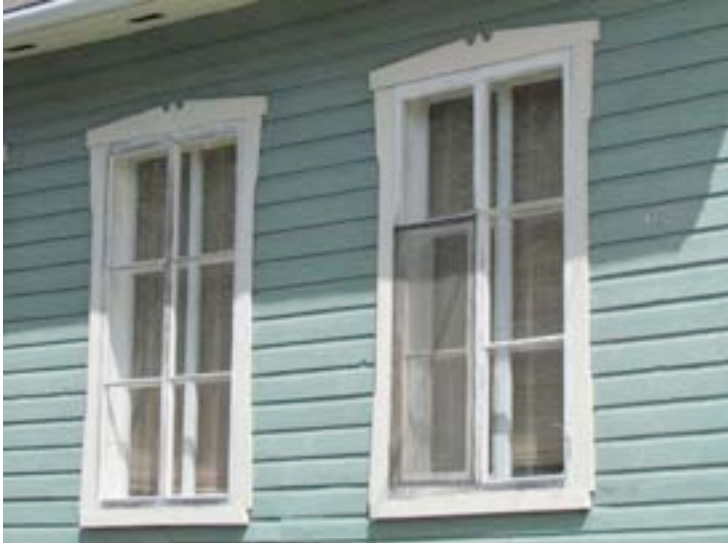
Fenêtres à battants à six grands carreaux (avec leurs contre-fenêtres très bien préservées) dont la proximité est révélatrice de la fonction d'origine de l'édifice : une ancienne école de rang. 81, rang Saint-François, Saint-Urbain. IMG_9481.jpg
