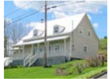
Le 195, rang Saint-Antoine Nord, Baie-Saint-Paul. IMG_4799.jpg
