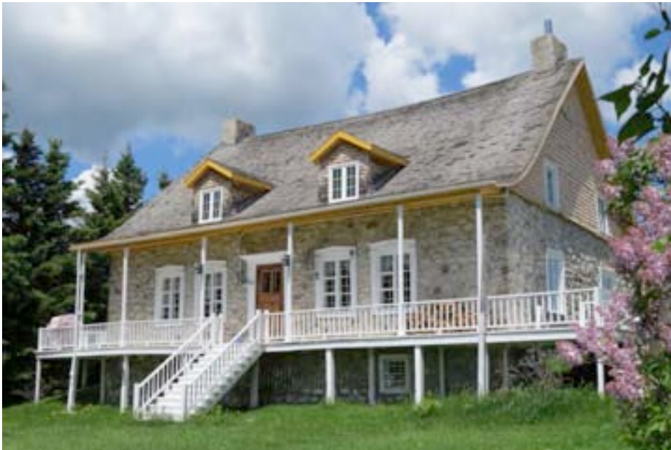
La maison Duchesne dit Lapierre en 2014. Deux lucarnes ont été ajoutées et la structure de pierre de l'édifice, érigé vers 1783 et parfaitement entretenu, est désormais visible. 2072, route du Fleuve, Les Éboulements. BIMG_0901.jpg
