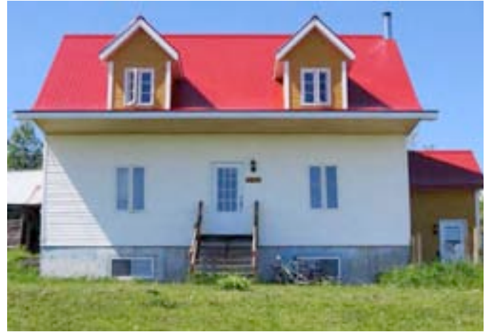
Le 1929, route du Fleuve, Les Éboulements, en 2014. D'importants travaux ont permis la mise en place de nouvelles fondations et de lucarnes. Bien que ces dernières soient tout à fait appropriées sur ce genre d'édifice, leur volume aurait eu avantage à se rapprocher de celui des lucarnes anciennes. BIMG_1020.jpg
