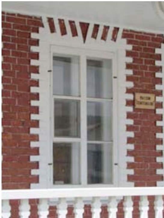
Jeu de briques mettant en valeur une fenêtre à battants à six grands carreaux. Ancien magasin général Alfred-Otis, 61, rue Saint-Jean-Baptiste, Baie-Saint-Paul.
