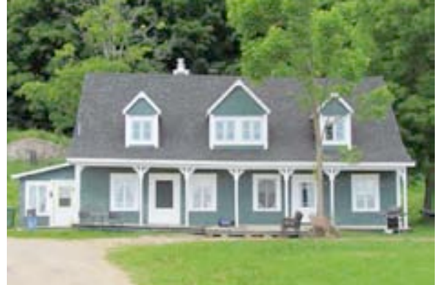
Le 65, rang des Éboulements-Centre, Les Éboulements, en 2014. Sur ce très vieil immeuble datant des environs de 1825, des pignons ont été ajoutés aux trois lucarnes, une intervention intéressante quoique non essentielle. IMG_8856.jpg
