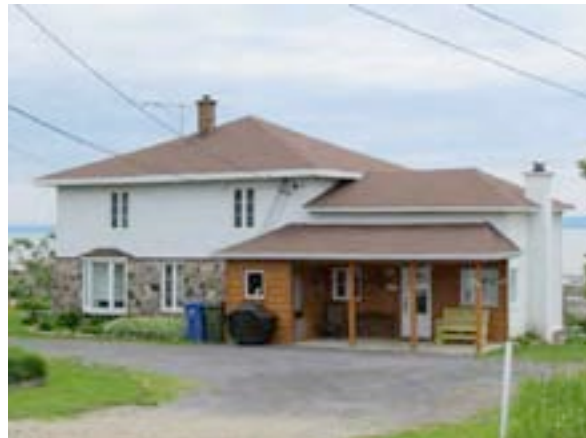
Les revêtements anciens sont disparus, tout comme les fenêtres et les portes traditionnelles. Différents types de matériaux sont en outre utilisés. Le 62, chemin de La Baleine, L'Isle-aux-Coudres. IMG_8054.jpg
