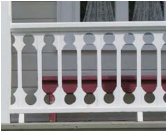
Garde-corps aux balustres découpés de la maison du capitaine Desgagnés, 284, rue Félix-Antoine-Savard, Les Éboulements. BIMG_0015.jpg
