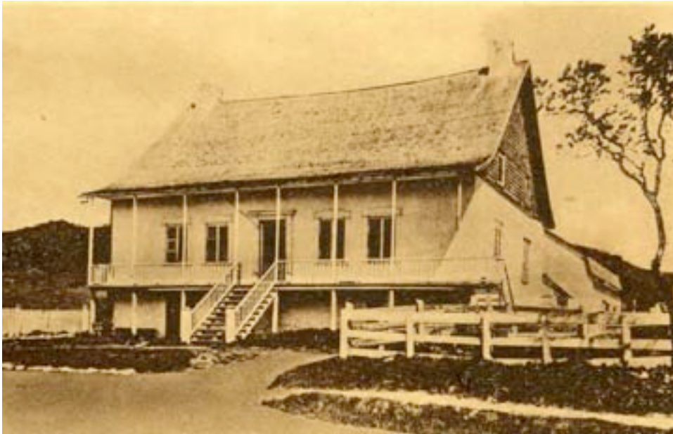
La maison Duchesne dit Lapierre, représentée sur une carte postale du début du 20 e siècle. 2072, route du Fleuve, Les Éboulements. CARC, collection Rosaire Tremblay. Les Éboulements, du fleuve, 2072.jpg
