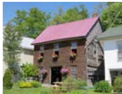
Exemple d'un bâtiment utilitaire, une ancienne boutique de forge, au 350, rue de la Plage aux Eboulements. BIMG_1230.jpg
