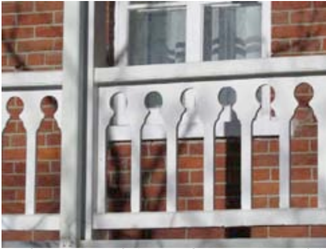
Garde-corps aux balustres découpés, un modèle très peu courant. Maison Arsène-Hidola-Simard, 14-16, rue Ambroise-Fafard, Baie-Saint-Paul. IMG_3045.jpg
