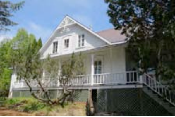
Lucarne triangulaire du 344, rue Félix-Antoine-Savard, Les Éboulements. BIMG_0091.jpg
