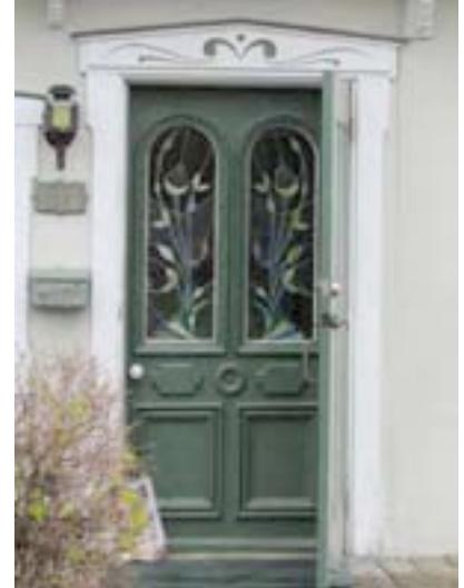
Porte à vitrage double à arc plein cintre avec doubles caissons sur la partie inférieure. Maison Danielson, 87, rue Saint-Joseph, Baie-Saint-Paul. IMG_4374.jpg
