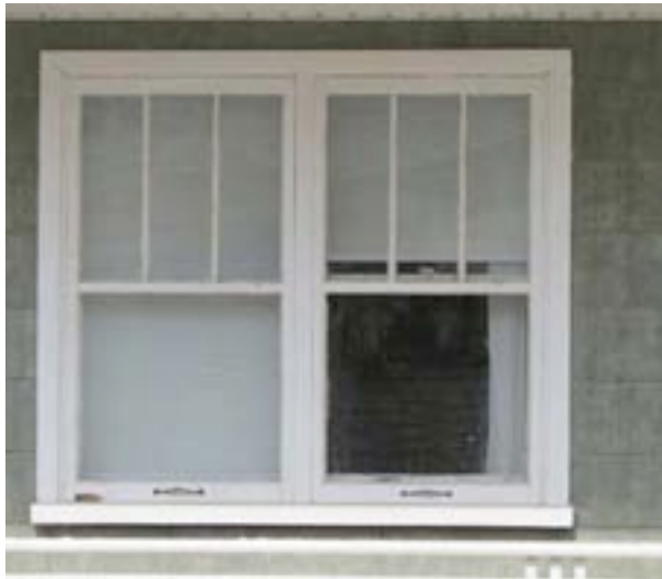
Fenêtres à guillotine jumelées à petits-bois très bien préservées au 910, rue Saint-Édouard, Saint-Urbain. BIMG_1667.jpg
