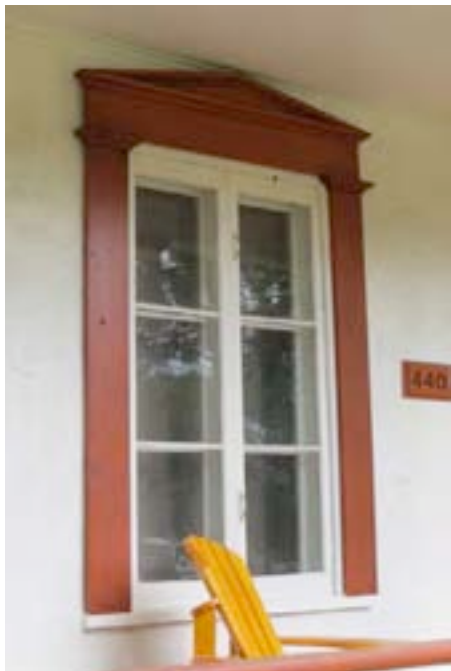
Fenêtres à battants à six carreaux avec chambranle et corniche au 440, rue Saint-Édouard, Saint-Urbain. BIMG_2007.jpg
