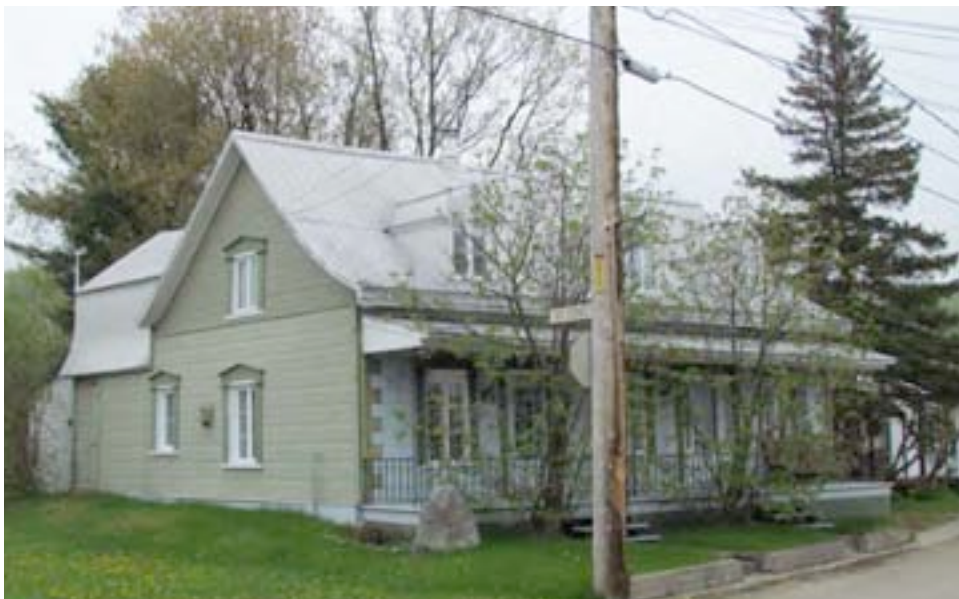
Le 49, rue Saint-Joseph, en 2014. La mise en place d'un parement moderne aux murs pignons a quelque peu altéré l'authenticité de l'édifice, qui était notamment caractérisé par un revêtement de planches imitant la pierre de taille. On remarque aussi que ces belles grandes galeries n'étaient pas, autrefois, nécessairement délimitées par un garde-corps. BIMG_4488.jpg
