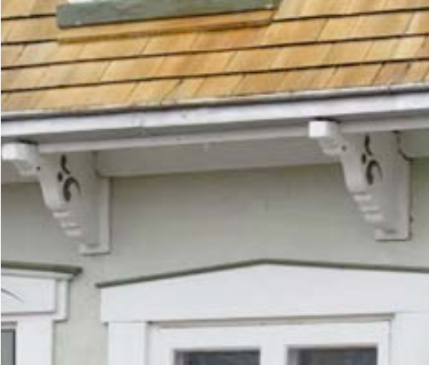
Consols d'avant-toit, des composantes relativement rares dans Charlevoix. On peut les admirer au 87, rue Saint-Joseph, Baie-Saint-Paul. IMG_4370.jpg
