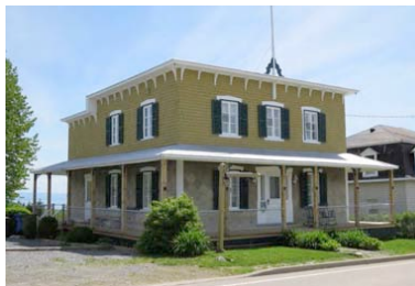
Exemple d'édifice à toit plat, la maison Joseph-Hector-Tremblay au 2424, route du Fleuve, Les Éboulements. En bordure de la corniche, on retrouve des consoles.
