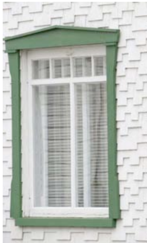
Fort intéressante fenêtre à imposte à petits-bois sur un édifice datant de 1952, une composante plutôt rare. 726, rue Saint-Édouard, Saint-Urbain. BIMG_1706.jpg
