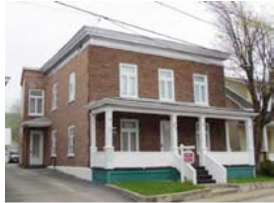
Exemple de maison à toit plat, le 43, rue Saint-Joseph, Baie-Saint-Paul. IMG_4511.jpg
