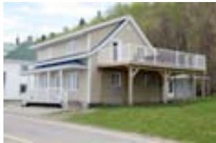
Le 1368, rue Principale, Petite-Rivière-Saint-François. BIMG_5747.jpg
