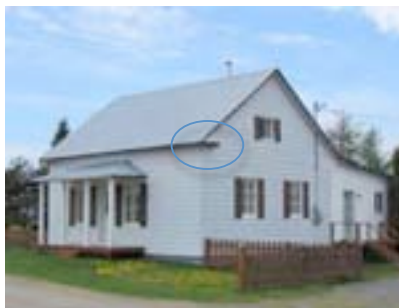
Exemple de maison québécoise d'inspiration néoclassique, le 211, 5 e Rang, Saint-Hilarion. Le cercle indique le retour de corniche. IMG_6230.jpg
