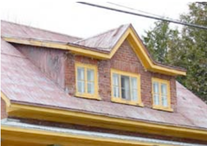
Autre version de la lucarne d'ornement charlevoisienne, recouverte de brique en façade avant et surmontée du fronton distinctif. 50, rue Sainte-Anne, Baie-Saint-Paul. IMG_5681.jpg
