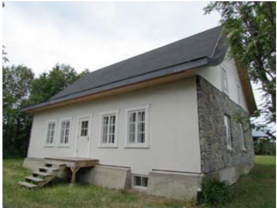
Le 110, chemin de La Baleine, L'Isle-aux-Coudres, en 2014. À l'issue de récents travaux, le revêtement de bardeau de bois (qui n'était peut-être pas d'origine) a été remplacé par un enduit et un matériau moderne s'apparentant à la pierre. De nouvelles fenêtres semblables au modèle original ont été mises en place. IMG_8039.jpg
