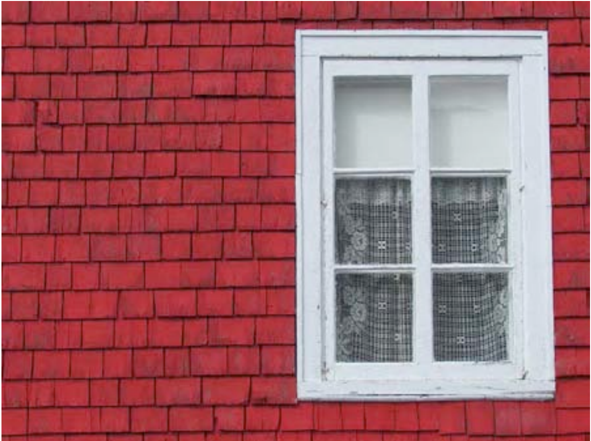
Fenêtre à battants à six grands carreaux et revêtement de bardeau de bois, sur un des rares édifices de Saint-Urbain ayant conservé de telles caractéristiques : le 465, rue Sainte-Anne. IMG_6632.jpg
