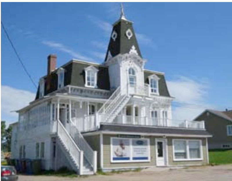
Le 2409-2415, route du Fleuve, Les Éboulements, en 2014. L'ajout d'un corps secondaire au rez-de-chaussée et d'un escalier menant au deuxième étage a altéré l'intégrité de l'édifice. Heureusement, on a préservé des composantes distinctives, comme la tour et la corniche à consoles. BIMG_0393.jpg
