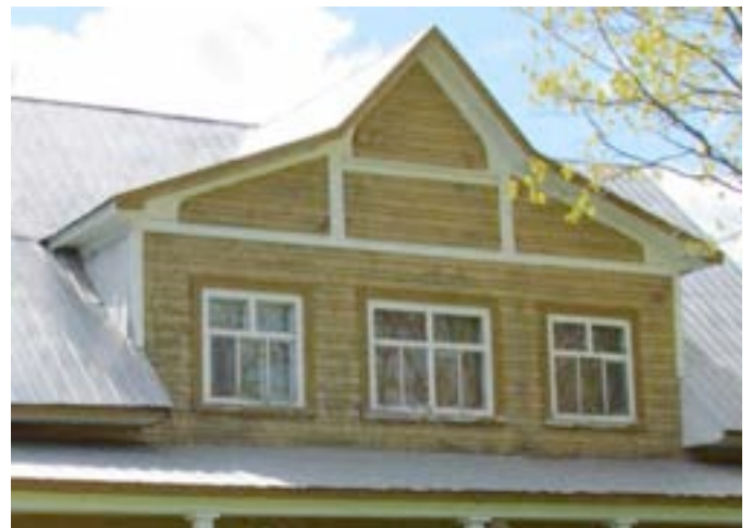
Une version très élaborée de la lucarne d'ornement, revêtue de bardeau de bois et surmontée d'un fronton. 357, chemin Saint-Laurent, Baie-Saint-Paul. IMG_4935.jpg
