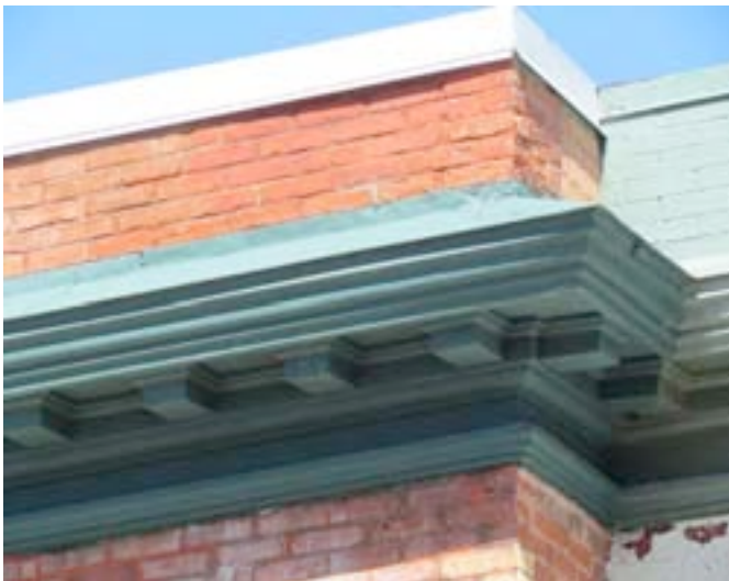
Corniche à modillons. 36-38, rue Saint-Jean-Baptiste, Baie-Saint-Paul. IMG_4370.jpg
