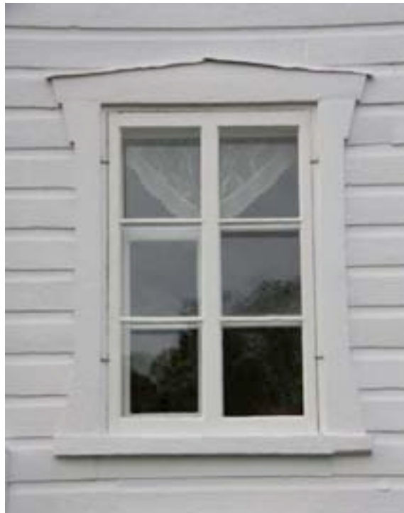
Fenêtre à battants à six grands carreaux et sa contre-fenêtre identique, le modèle le plus usuel de fenêtre traditionnelle. Le revêtement mural est en planche à feuillure. 9, rue Bergeron, Petite-Rivière-Saint-François.
