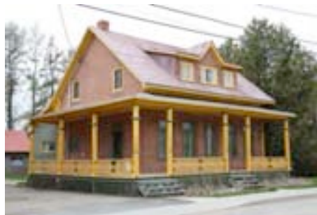
Exemple de maison québécoise d'inspiration néoclassique, le 50, rue Sainte-Anne, Baie-Saint-Paul. BIMG_6038.jpg
