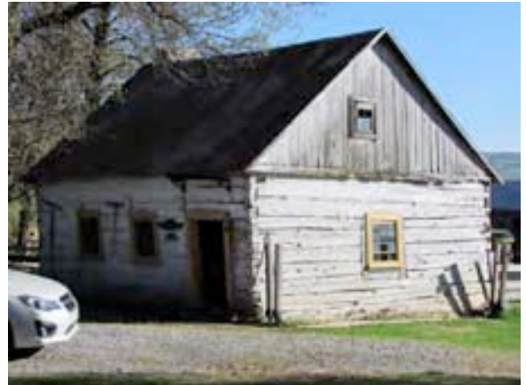
Exemple de maison de colonisation, la maison Tremblay au 69, chemin Saint-Laurent, Baie-Saint-Paul. IMG_5034.jpg
