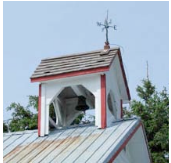
Clocheton révélateur de la fonction d'origine de l'édifice, une école de rang érigée en 1922. 74, rang Saint-Jean-Baptiste, Saint-Urbain. IMG_7670.jpg
