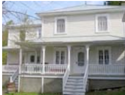
Façade de la maison du capitaine Desgagnés, 284, rue Félix-Antoine-Savard, Les Éboulements. BIMG_0012.jpg
