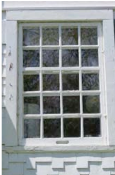
Contre-fenêtre à petits carreaux, très bien préservée, sur un édifice des années 1940. 357, rue Félix-Antoine-Savard, Les Éboulements. BIMG_0137.jpg
