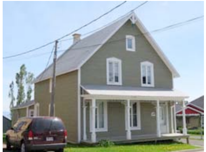
Le 2400, route du Fleuve, Les Éboulements, en 2014. Un nouveau revêtement, fort acceptable pour ce genre d'édifice, a été mis en place ainsi que des imitations d'aiseliers au sommet des colonnes. La seule intervention dommageable est la disparition des éléments découpés en bordure du toit. BIMG_0595.jpg
