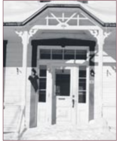
Figure 32 Porte avec imposte vitrée.
