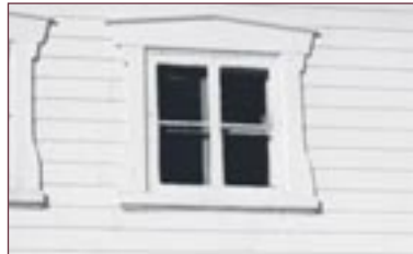
Figure 65 Modèle de chambranle le plus répandu sur le territoire de la MRC de Charlevoix.
