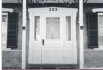
Figure 29 Porte avec baies latérales.
