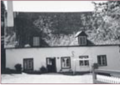
Figure 22 Bâtiment en pierre revêtu de crépi.
