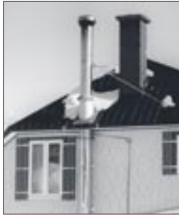
Figure 62 Deux générations de cheminées.
