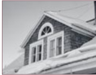
Figure 44 Lucarne centrale percée d'une fenêtre jumelée et d'une imposte en hémicycle que l'on retrouve souvent dans la région.
