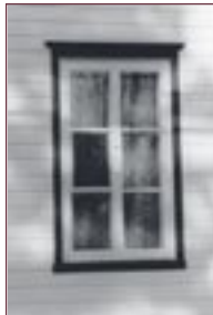
Figure 35 Fenêtre à battants à grands carreaux.
