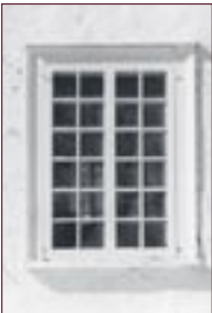
Figure 34 Fenêtre à battants à petits carreaux.
