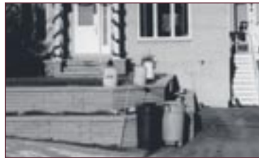
Figure 95 Aménagement de type banlieusard composé de talus, de murs de soutènement en interblochs de béton et de surfaces asphaltées. À déconseiller.
