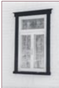
Figure 36 Fenêtre à battants avec imposte.
