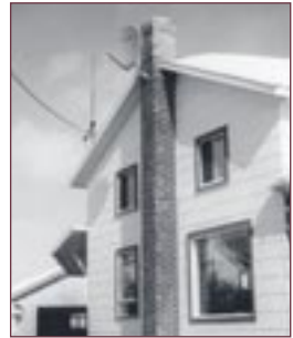
Figure 63 Massif de cheminée construit à l'extérieur.
