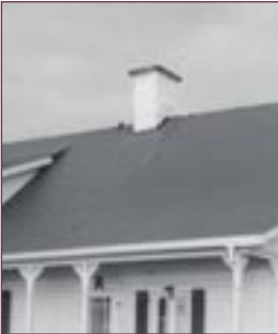
Figure 61 Cheminée en pierre.
