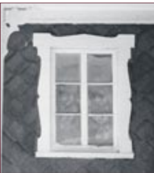
Figure 66 Autre modèle de chambranle.
