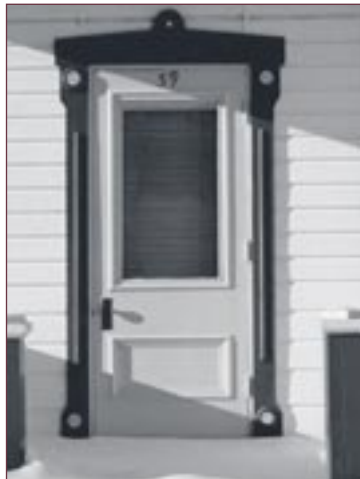
Figure 30 Porte à panneaux avec chambranle ouvragé.
