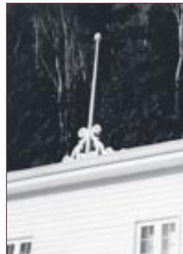
Figure 75 Mât au sommet d'une corniche.
