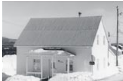
Figure 21 Toiture en tôle profilée.
