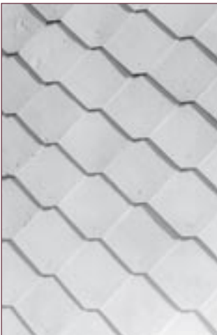
Figure 26 Bardeaux d'amiante-ciment.
