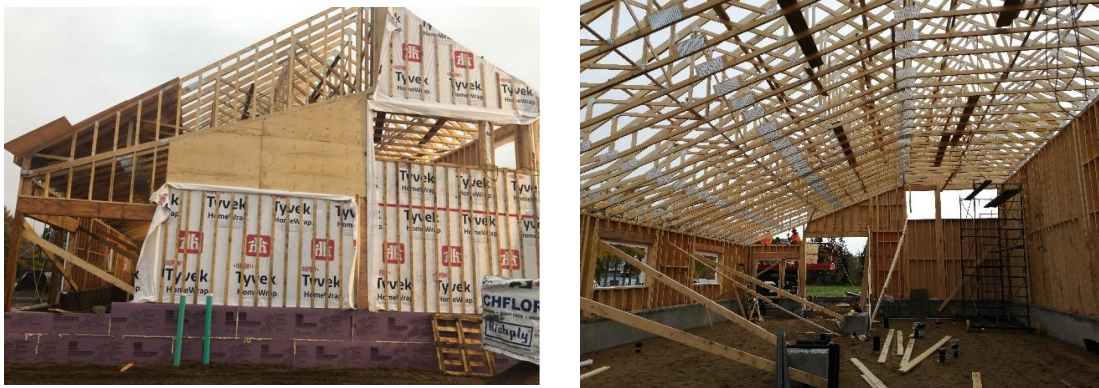
Figure 6 et 7 : Ossature légère en bois
