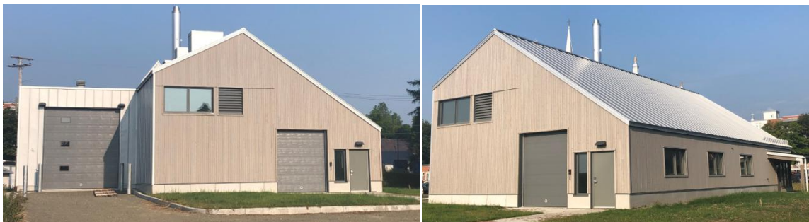
Figure 2 et 3 : Vue extérieure de la centrale d'énergie à la biomasse
